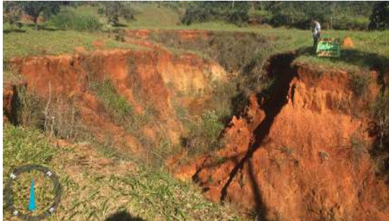
Figura 42 – Voçoroca ao longo da BR-479.
