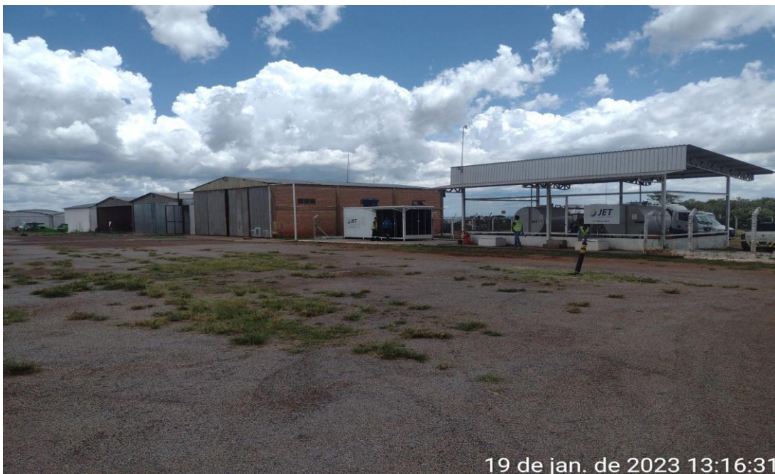
Figura 11 - Estruturas de apoio do Aeródromo do Planalto Central.
